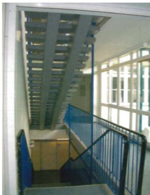
Offene Treppenanlagen, die zu einer erhöhten Brandausbreitungsgefahr sowie zu einer erhöhten Gefahr für die Flucht und Rettung führen.
