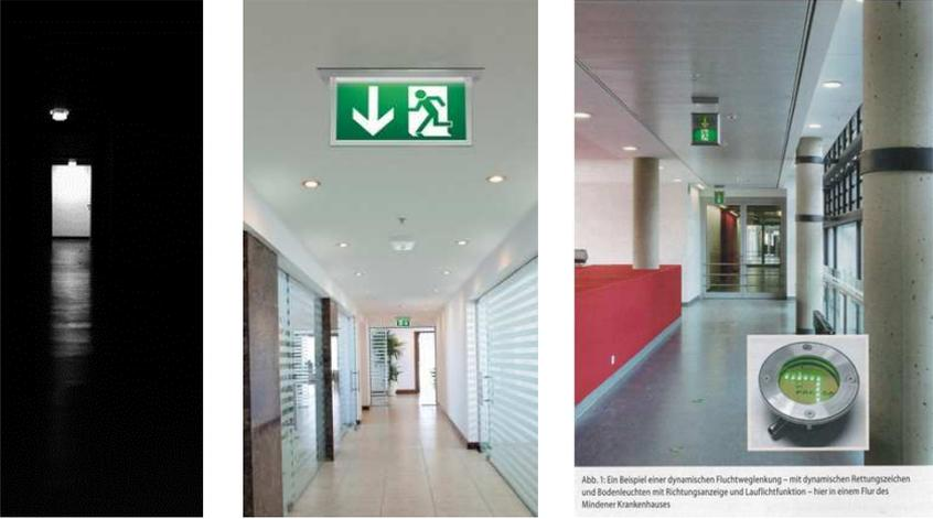
Abb. 1: Ein Beispiel einer dynamischen Fluchtweglenkung – mit dynamischen Rettungszeichen und Bodenleuchten mit Richtungsanzeige und Lauflichtfunktion – hier in einem Flur des Mindener Krankenhauses
