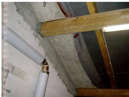
Brandwandkopf durch beiderseits 0,50 m rauskragende feuerbeständige Platte nach § 30 (5) NBauO.
