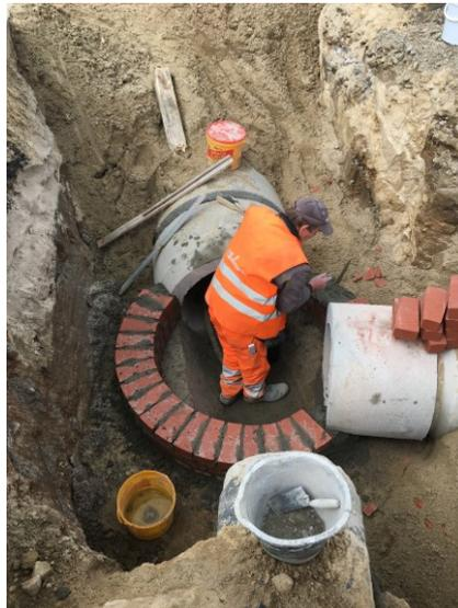
Der alte Kanal war hydraulisch überlastet und musste durch einen Kanal mit der Dimension DN 800 ersetzt werden.
