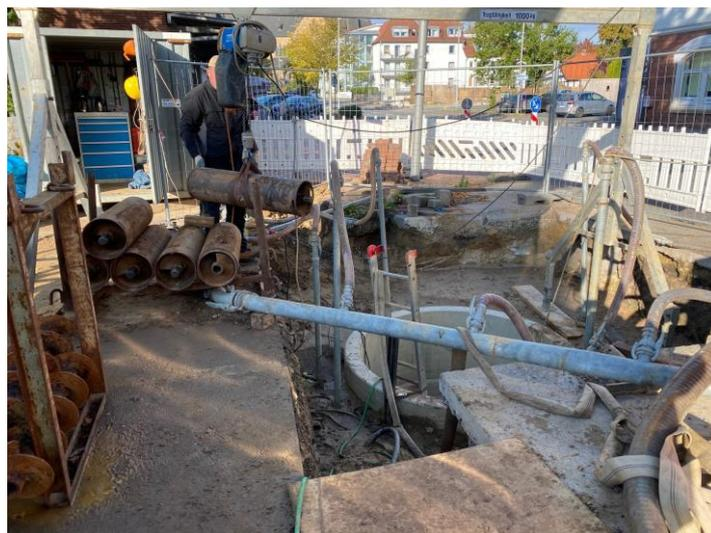
Im OT Holzhausen wurde die vorhandene Versickerungsanlage „Maalstätte“ angepasst und geändert. Für die im Bereich des B-Plans „Im Sundern“ geplante Bebauung wurden Regen- und Schmutzwasserkanäle neu verlegt.
